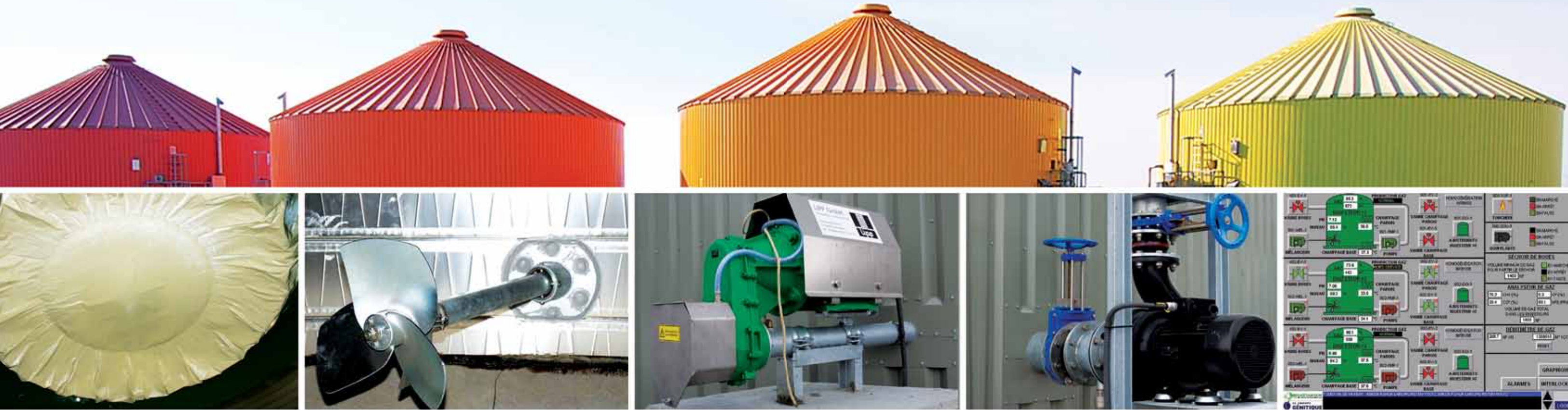
Réserve intégrée de biogaz à pression atmosphérique permettant d'emmagasiner la production de biogaz pour une utilisation en temps utile.
